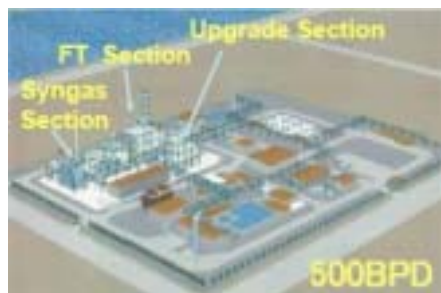
天然ガス液体燃料化実証実験用プラント (日本GTL技術研究組合)
